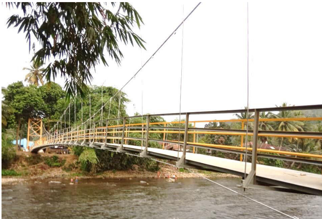
Pembangunan Jembatan Kp. Danau Rantau Simalenang Kec. Linggo Sari Baganti Tahun 2019
