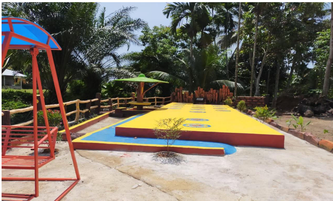
Bangunan IPAL Komunal Nagari Kambang Timur Kec. Lengayang Tahun 2019
