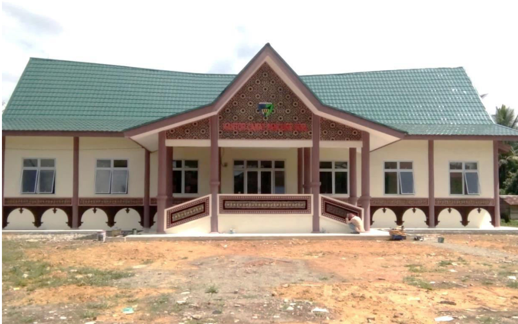
Pembangunan Kantor Camat Pancung Soal Kec. Pancung Soal Tahun 2019
